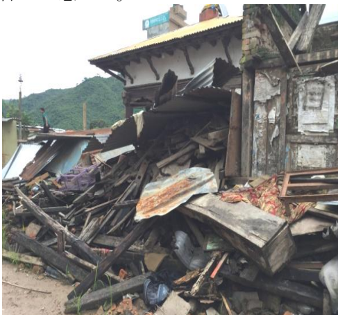
サンク村の倒壊した家
